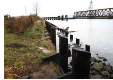
Creosote timber bulkhead
